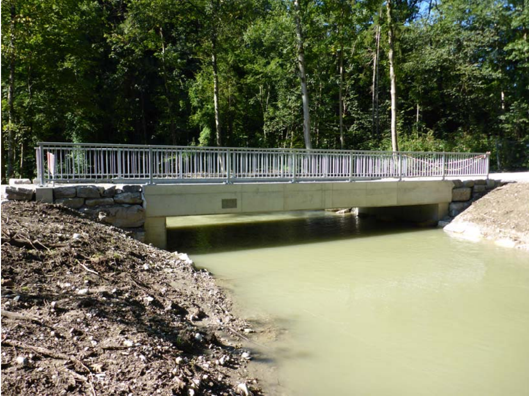
Die fertiggestellte Brücke über den Mühlbach ist nun befahrbar
